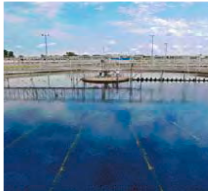
Blick auf eines der 15 neuen Nachklärbecken
