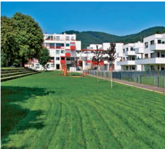
Wohnhausanlage der ARWAG in der „Stadt des Kindes“
